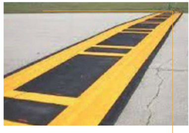
HOLDING POSITION POSTA A PROTEZIONE DELL'ILS
