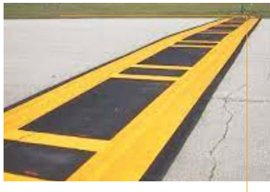
HOLDING POSITION POSTA A PROTEZIONE DELL'ILS
