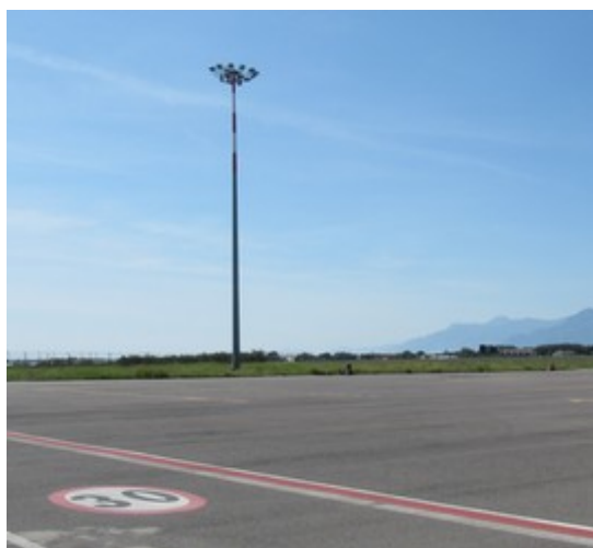
Figura 2.6: torre faro sul lato sinistro del piazzale
